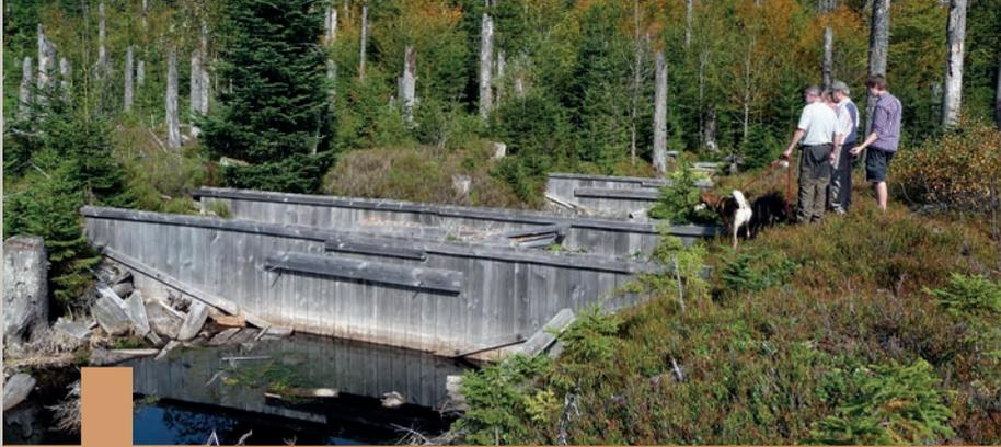
*Holzspundwände sollen alte Entwässerungsgräben verschließen und so den Wasserhaushalt der Moore verbessern.*
