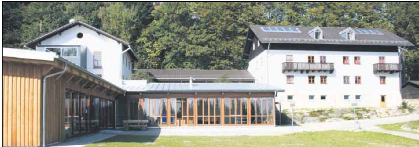
Ehemalige Zollhäuser bilden das Grundgerüst des Jugendwaldheims „Wessely-Haus“. Für das Projekt „Natur-Mensch-Technik“ wurde ein moderner Holzbau angefügt.
