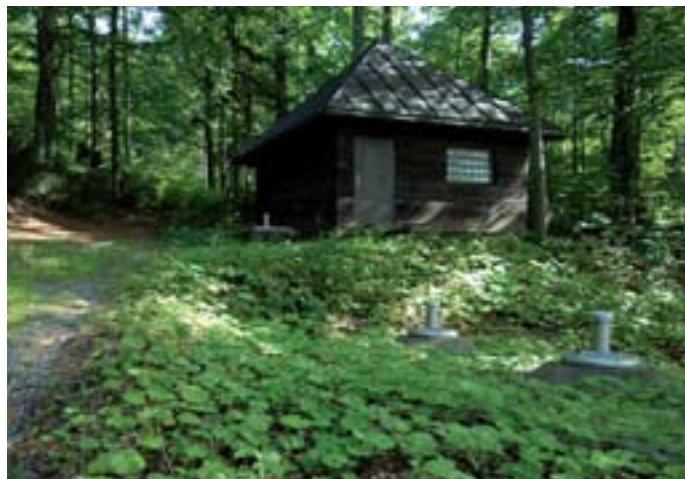
Entsäuerungsanlage der kommunalen Trinkwasserversorgung St. Oswald. Anlage und Betrieb bedurften einer Ausnahmegenehmigung (Foto: Hans Kiener)
