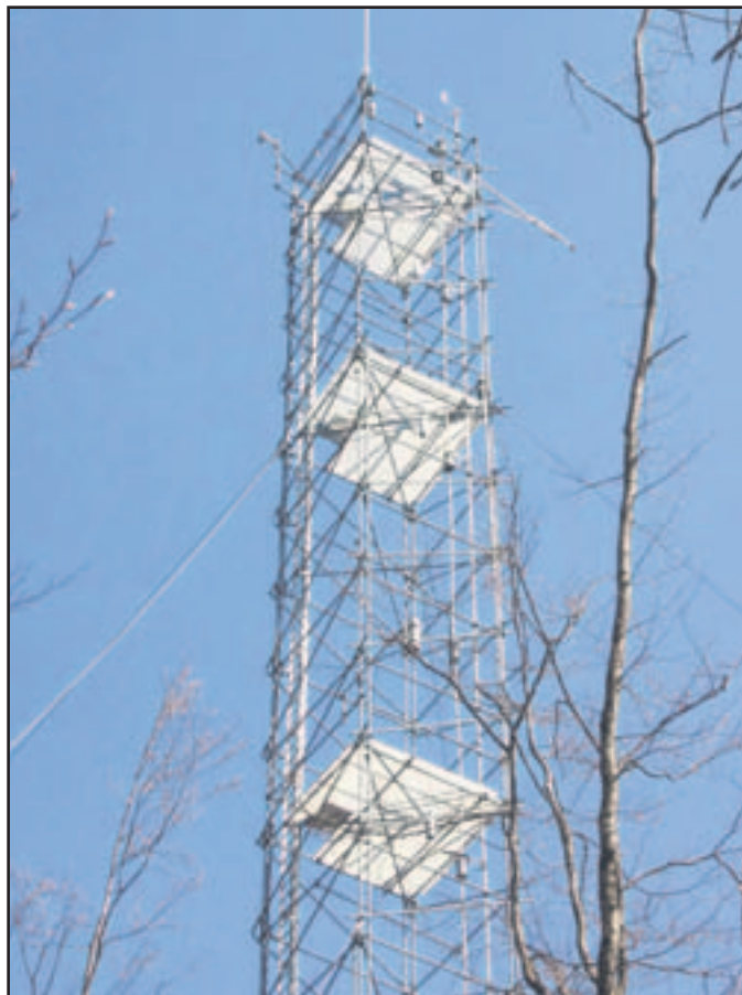
Der 50 Meter hohe Messturm ragt über die Baumkronen hinaus.
