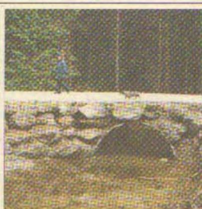
Bei den Renaturierungsmaßnahmen am Schmalzbach wurden Stahl-Halbrohre verwendet. Dadurch bleibt die Gewässersole in natürlichem Zustand. **Seite 3**
