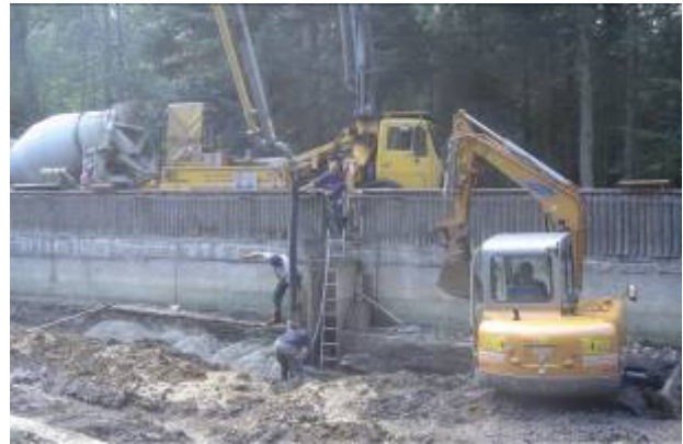
Abbildung 29: Abdichtung eines Lecks am Damm des Bibergeheges (Foto: W. Kirchner).
