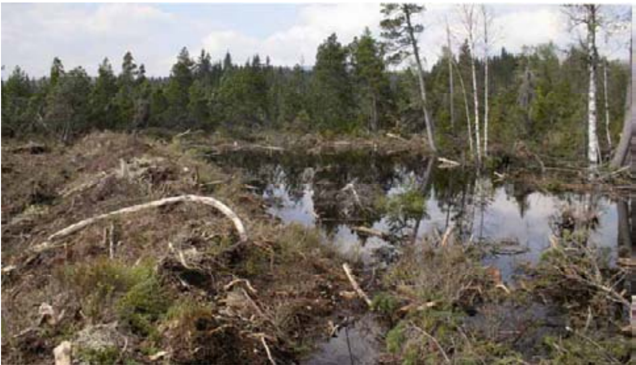
Abbildung 9: Moorrenaturierung erfolgt u. a. mit dem Aufstau ehemaliger Entwässerungsgräben (Foto: R. Pöblmann).
