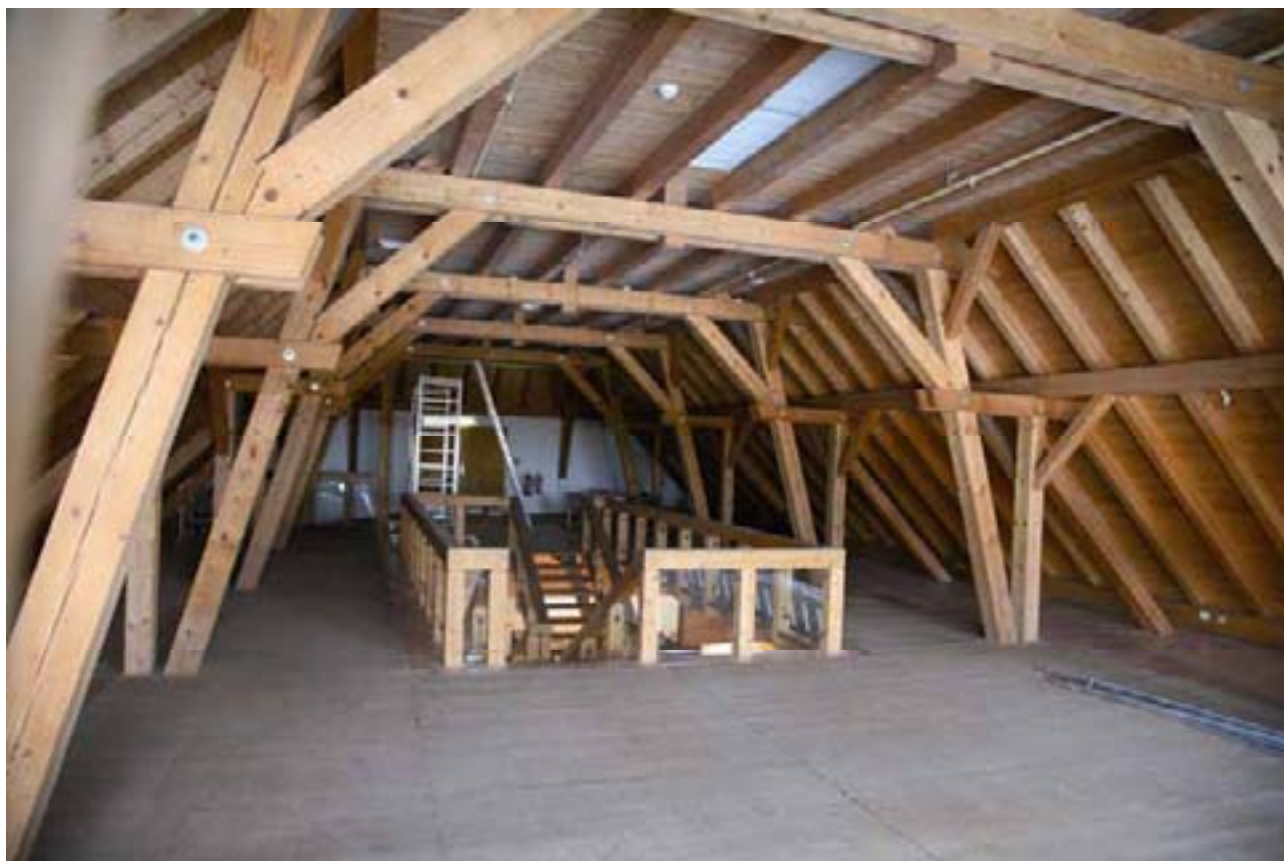
Abbildung 24: Während des gesamten Jahres liefen die Umbau-, Renovierungs- und Installationsarbeiten (Foto: W. Bäuml).
