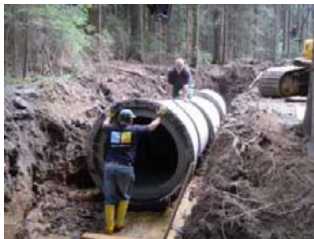
Abbildung 26: Für die Teilerneuerung des Fischottergeheges war eine temporäre "Bypass-Rinne" erforderlich (Foto: W. Kirchner).
