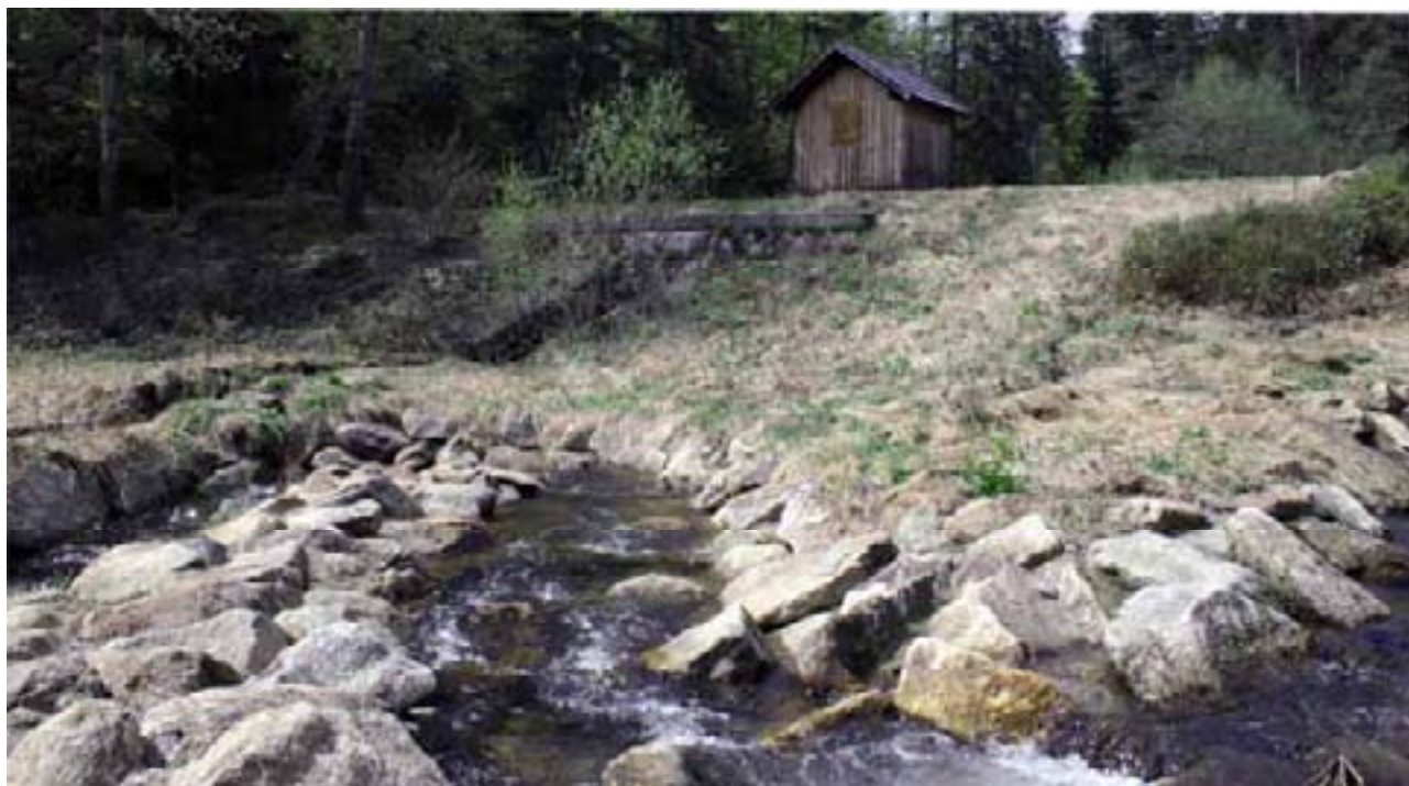
Abbildung 43: Die Knotenbachklause bleibt erhalten, eine Fischaufstiegshilfe trägt dem Naturschutz Rechnung (Foto: R. Pöhlmann)
