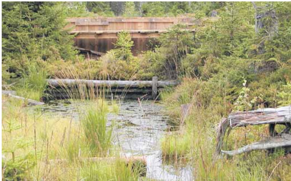
Die fertig gestellte Holzspundwand soll die beträchtliche Entwässerungswirkung des über drei Meter tiefen Grabens deutlich reduzieren. Mit der dadurch geförderten Regeneration des mooreigenen Wasserkörpers kann auch das Moorwachstum wieder stimuliert werden.
