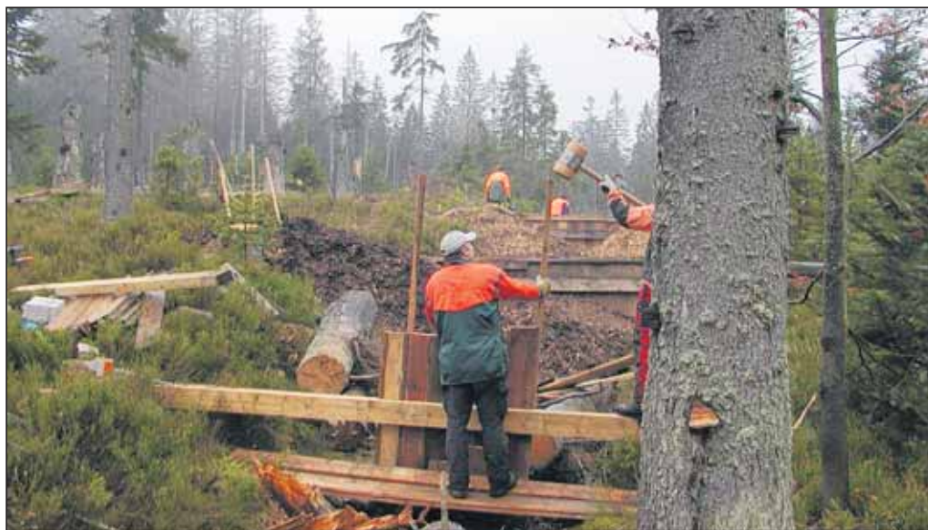
Dünne Federleisten werden in die Nut aneinander liegender Douglasienbohlen geschoben. Bei Wasserkontakt quillt das Holz auf und dichtet die Spundwand ab.
