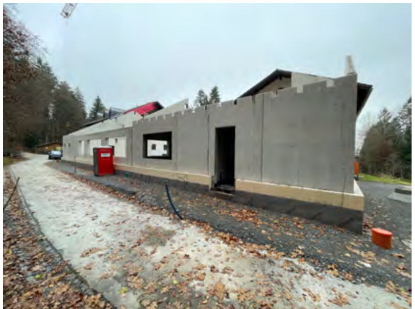
Der Rohbau des neuen Speisesaals konnte im vergangenen Jahr bereits errichtet werden.
